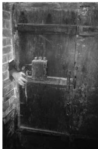
19. A bortároló ajtaja belülről, a kulcs a zárban, a lamellák felemelt állapotban a retesz elhúzva
