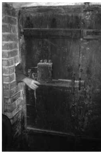
18. A bortároló ajtaja belülről, a kulcs a zárban, a lamellák felemelt állapotban, a retesz elhúzható
