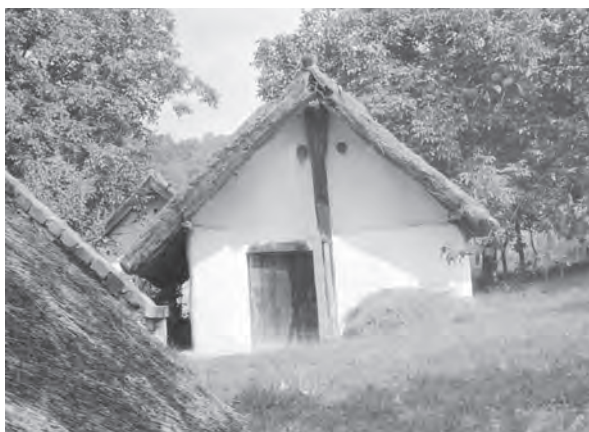
■ Kajárpéc. Faluból művelt szőlő, archaikus, ágasfás tetőszerkezetű présház pincéje (Józsa Tamás mérnök tanár, szakközépiskolai igazgató szíves közlése)
